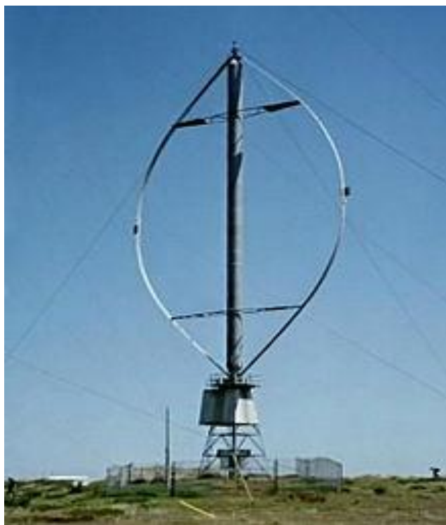
Slika 9. Vjetroelektrana s okomitim rotorom [21]
