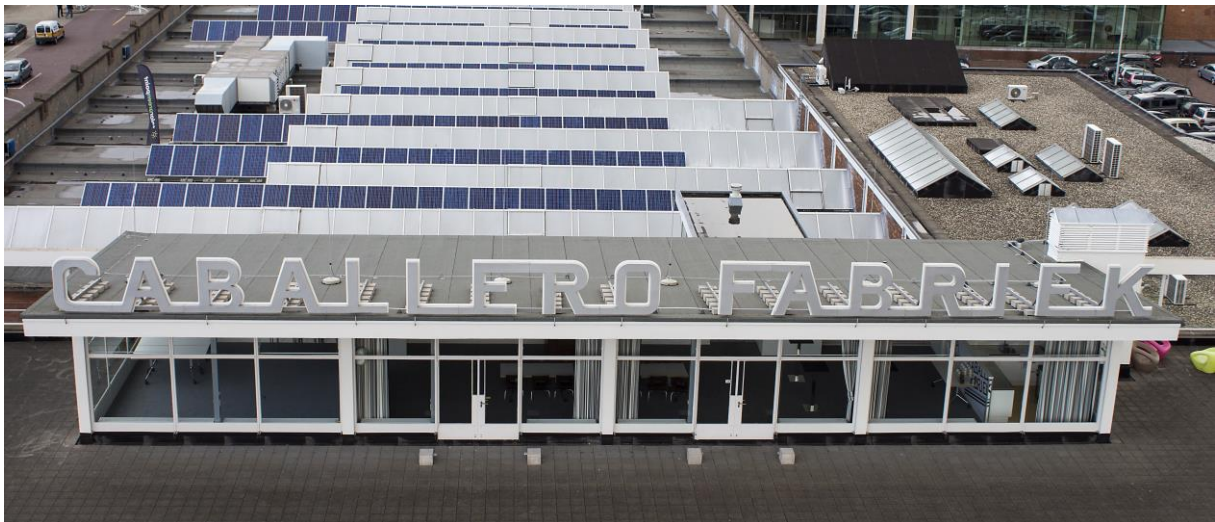
Slika 15. Solarni paneli na krovu Caballero tvornice u Haagu [29]
