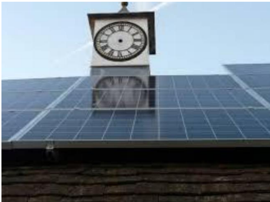
Slika 3. Zasjenjivanje fotonaponskih modula [1]
