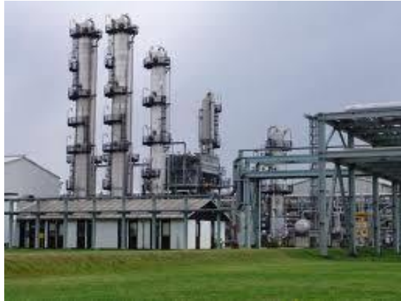
Slika 9. Centralna plinska stanica Molve [14]
