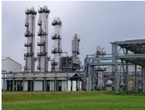
Slika 9. Centralna plinska stanica Molve [14]
