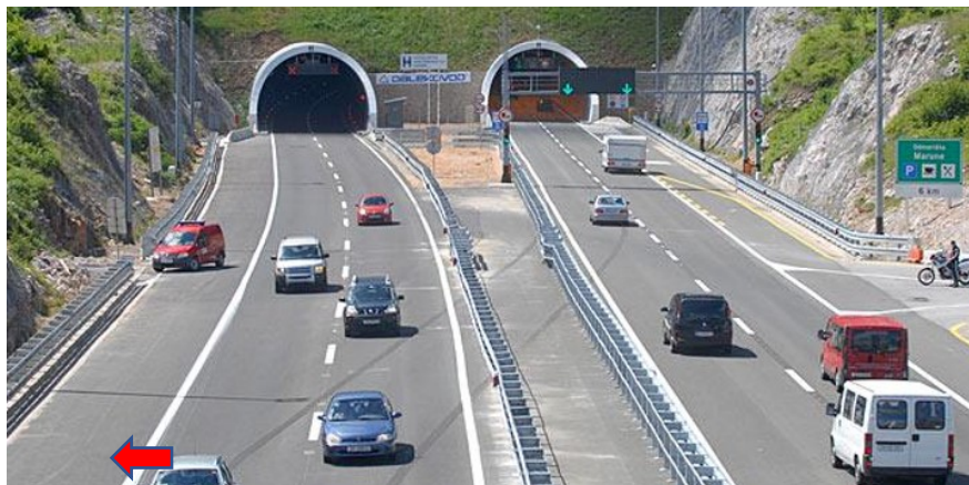
Slika 13 Zaustavni trak na autocesti [15]
