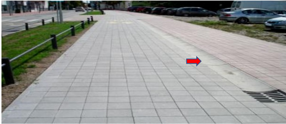
Slika 12 Rigol na pješačkoj stazi [14]
