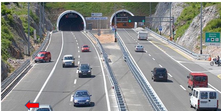
Slika 13 Zaustavni trak na autocesti [15]
