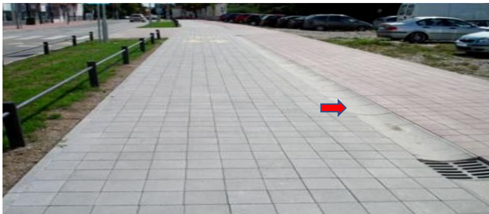
Slika 12 Rigol na pješačkoj stazi [14]
