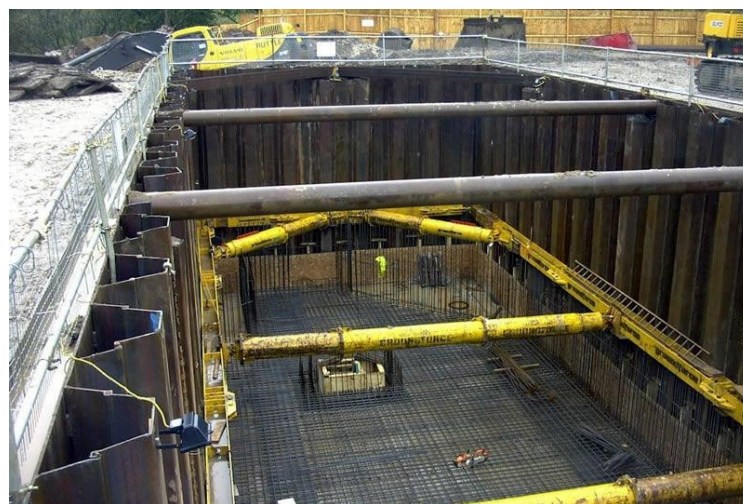
Slika 3. Čelični profili kao zaštita građevinske jame [11]
