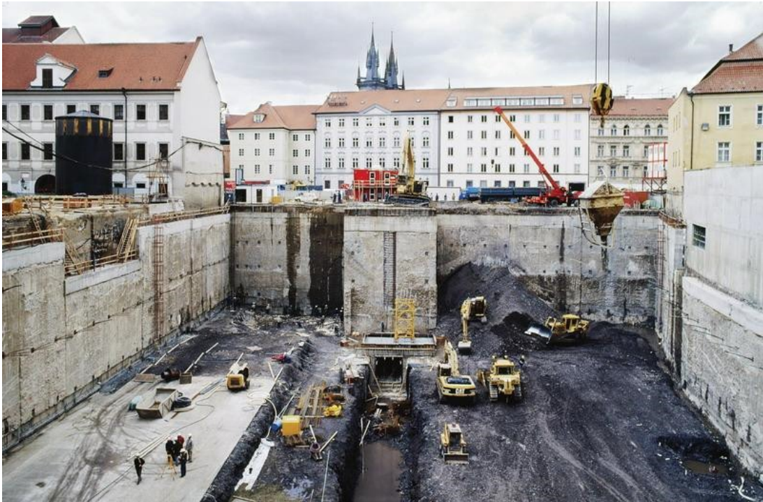
Slika 4. Armirano betonska dijafragma
