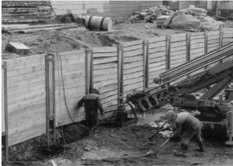
Slika 7. Zaštita berlinskim zidom od drvenih platica [2]
