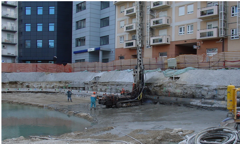
Slika 23. Mlazno injektiranje pomoću strojeva
