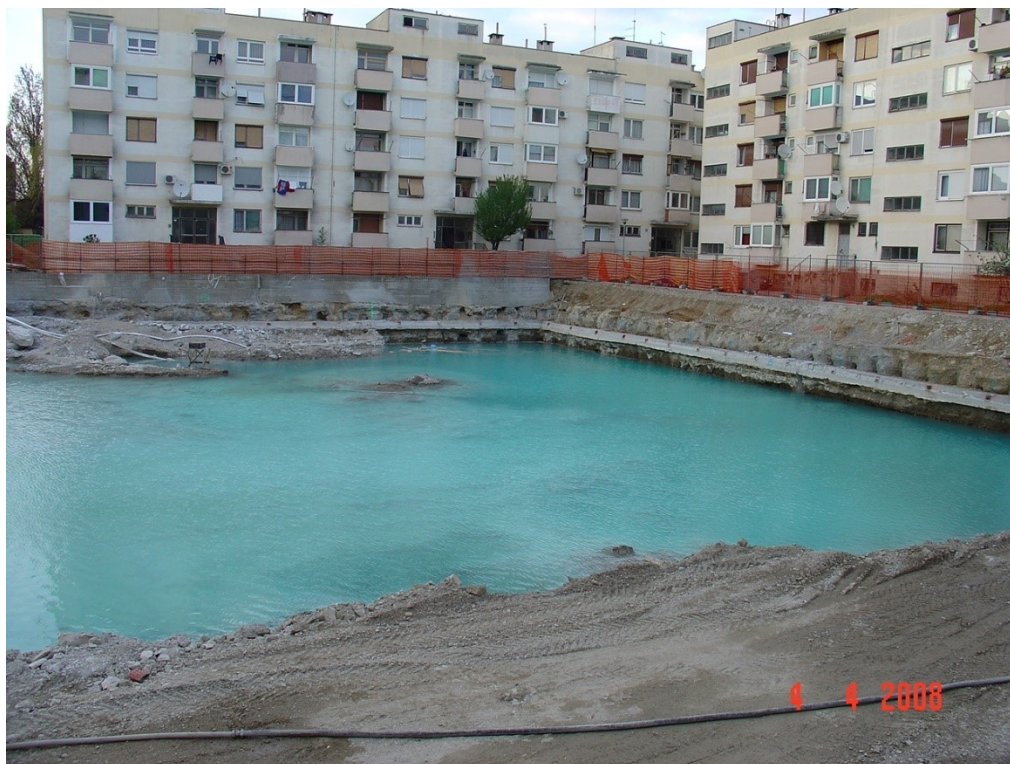
Slika 20. Podzemna voda u građevinskoj jami
