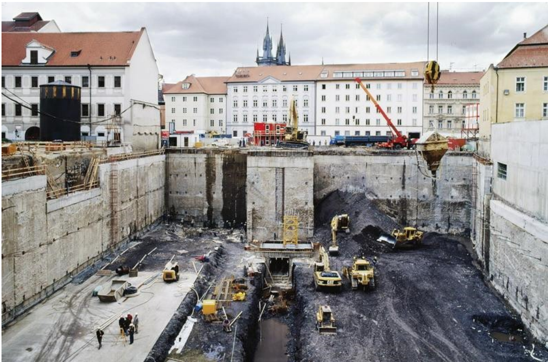
Slika 4. Armirano betonska dijafragma
