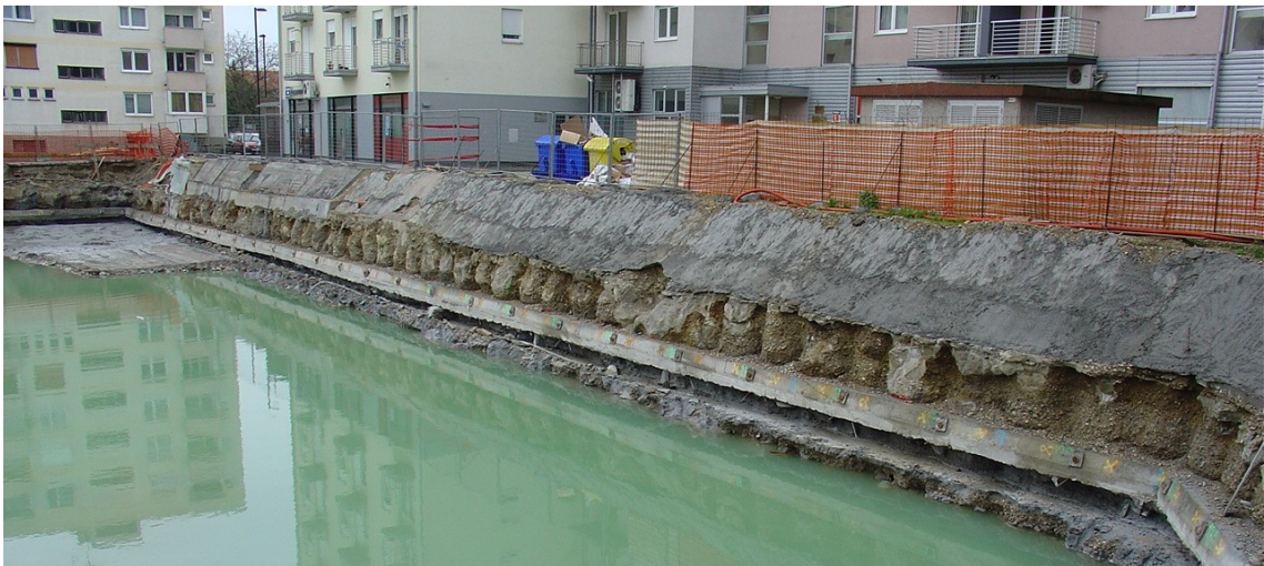
Slika 21. Izvedeni stupnjaci kao zaštitna konstrukcija
