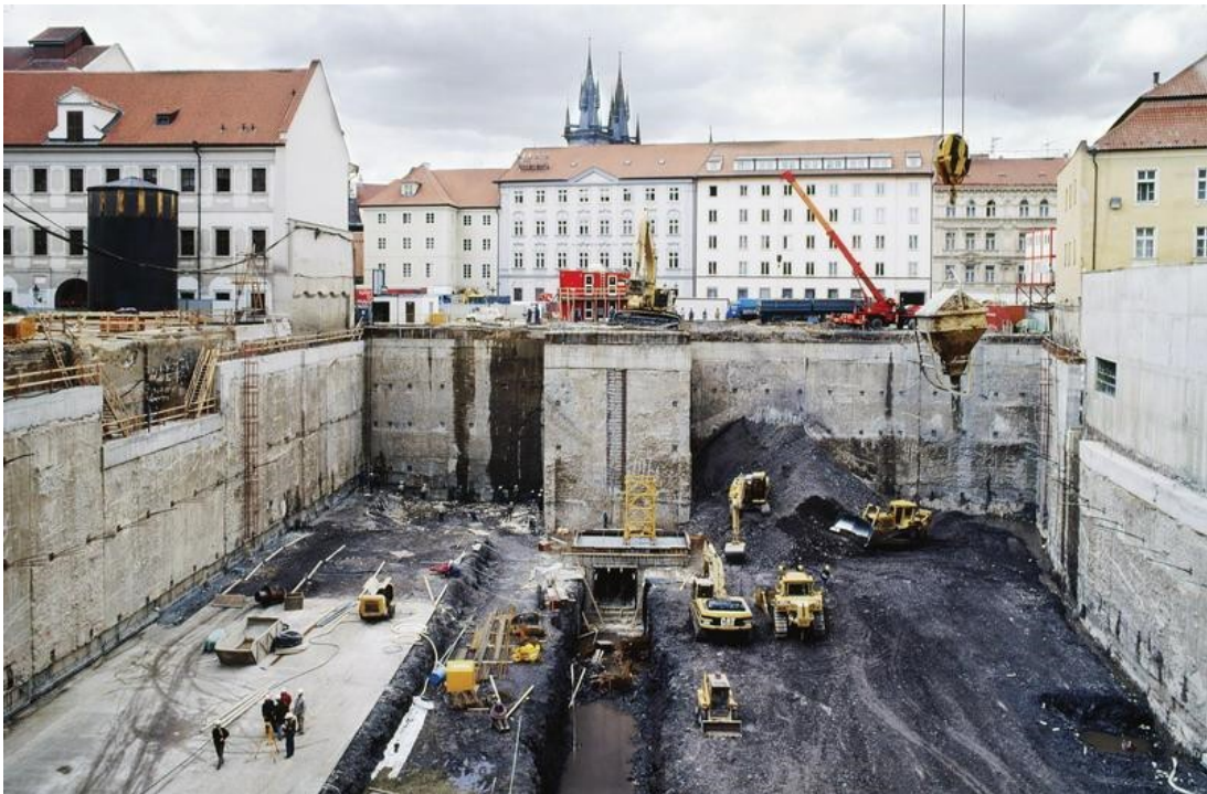
Slika 4. Armirano betonska dijafragma
