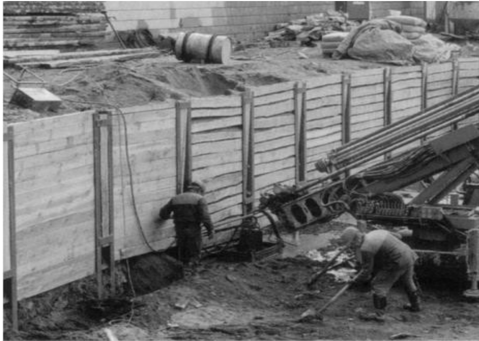
Slika 7. Zaštita berlinskim zidom od drvenih platica [2]
