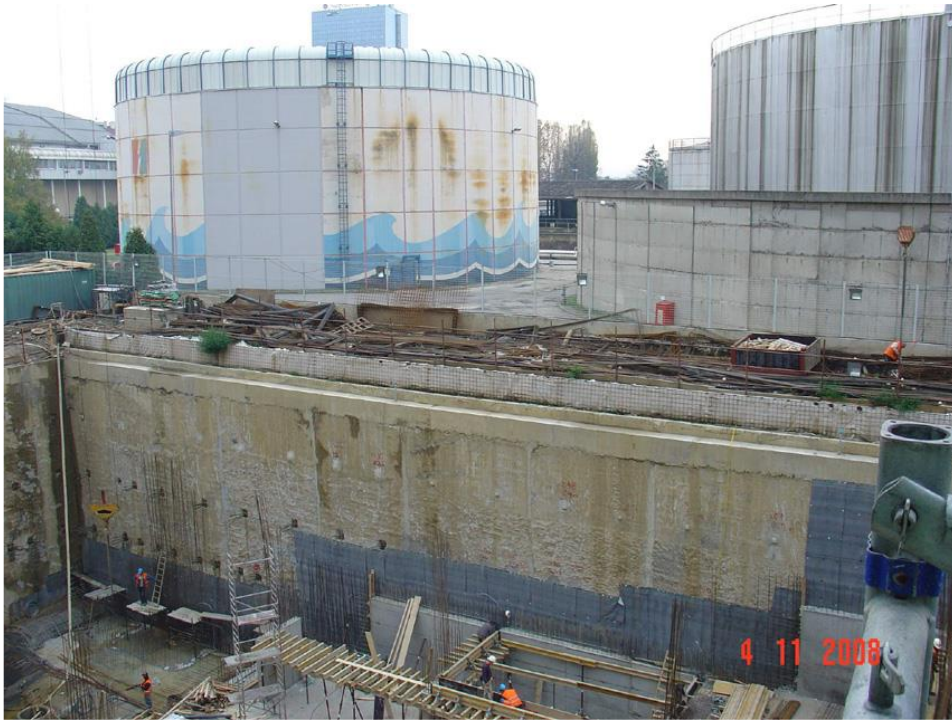
Slika 20. Južni dio građevinske jame i rezervoari toplane HEP-a [13]
