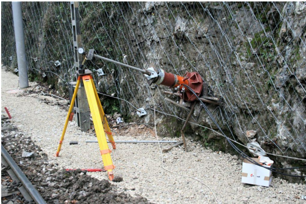
Slika 7. Ispitivanje sidara testom čupanja
