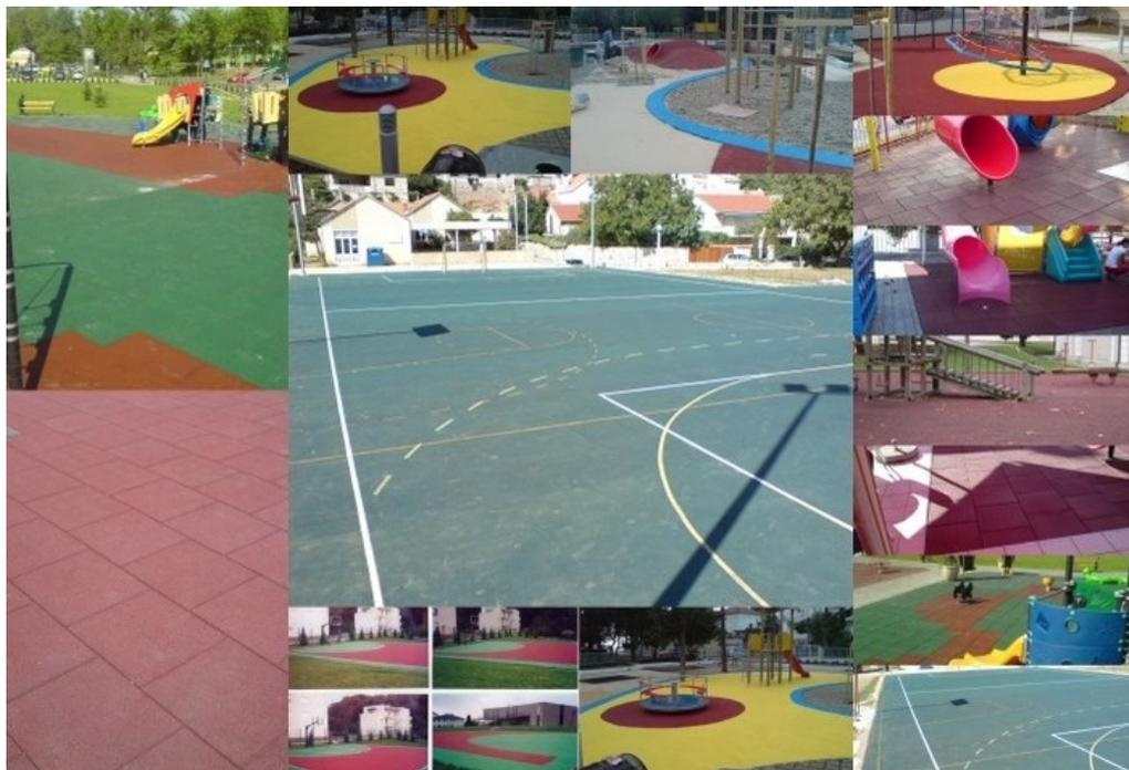
Slika 7. Reciklirane gumene podloge postavljene u svrhu sporta i rekreacije [11]
