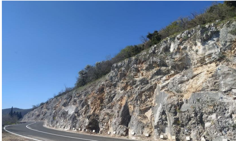
Slika 21. Sanacija padine ugradnjom zaštitne mreže ojačane čeličnom užadi te štapnih sidara (preuzeto s: https://www.geotech.hr/zastita-pokosa-na-dijelu-drzavne-ceste-d66-dionica-003-od-km-15000-do-km-23000/ )
