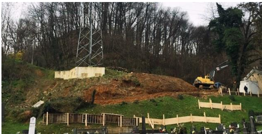
Slika 28. Sanacija klizišta kod groblja Dubovac
