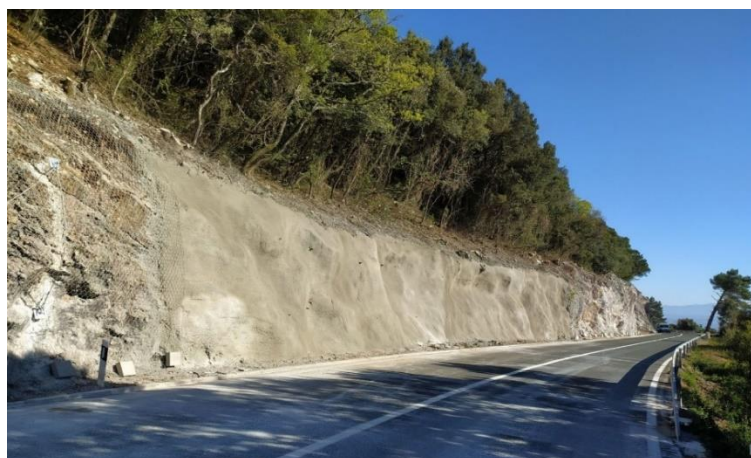
Slika 22. Sanacija padine ugradnjom mlaznog betona te samobušivih sidara
