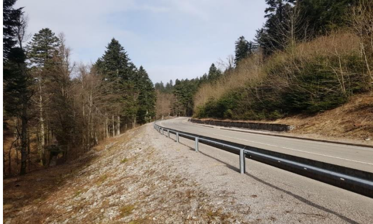
Slika 31. Sanirano klizište Vela Voda
