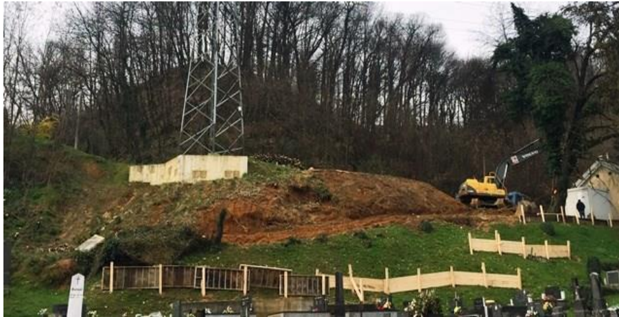
Slika 28. Sanacija klizišta kod groblja Dubovac
