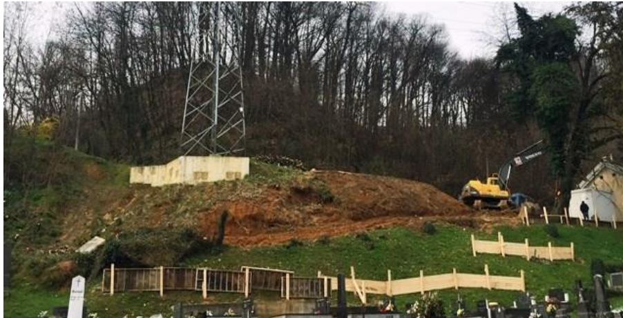
Slika 28. Sanacija klizišta kod groblja Dubovac
