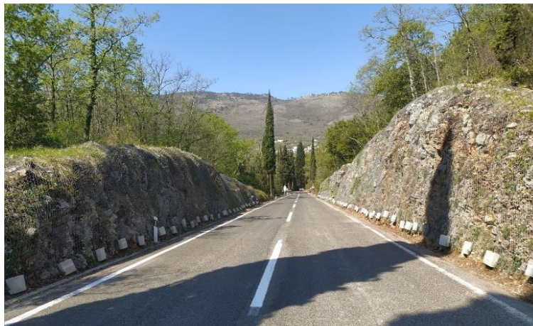
Slika 20. Prikaz izvedene zaštite postavljanjem zaštitne mreže
