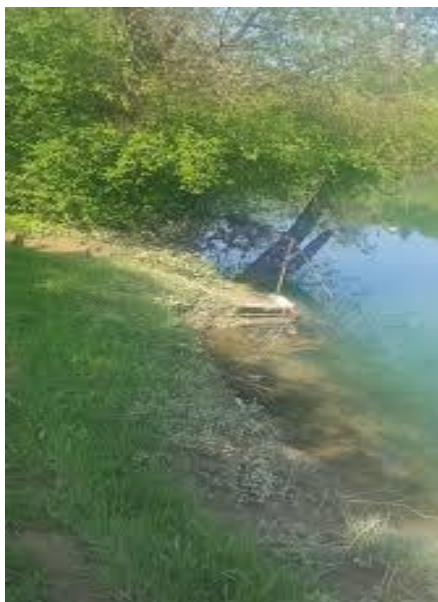
Slika 26. Prikaz postojećeg stanja prije sanacije
