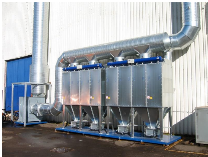
Slika 9 Primjer konvencionalnog uređaja za pročišćavanje zraka u industriji [35]
