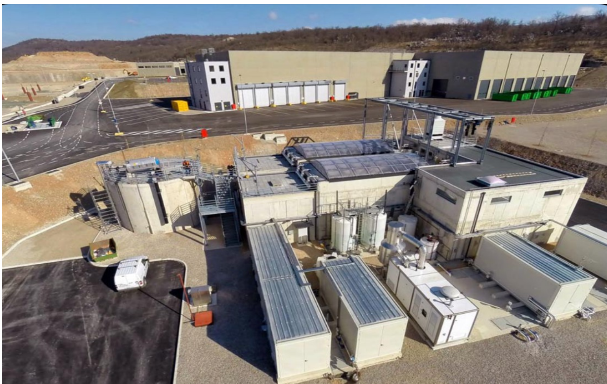
Slika 1: Prikaz postrojenja ŽCGO Mariščina [4]
