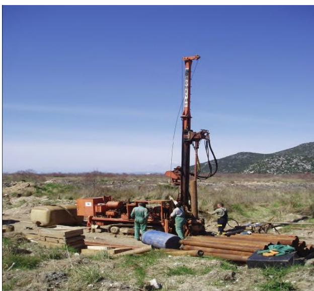
Slika 1 - Geotehničko istražno bušenje [1]
