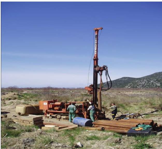
Slika 1 - Geotehničko istražno bušenje [1]
