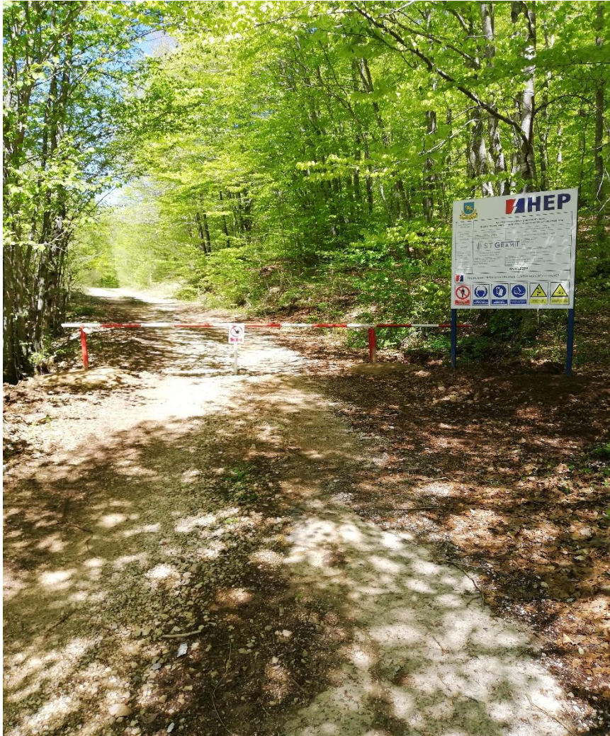
Slika 8. Izgradnja prometnice kod postojeće HE Sklope do naselja Studenci
