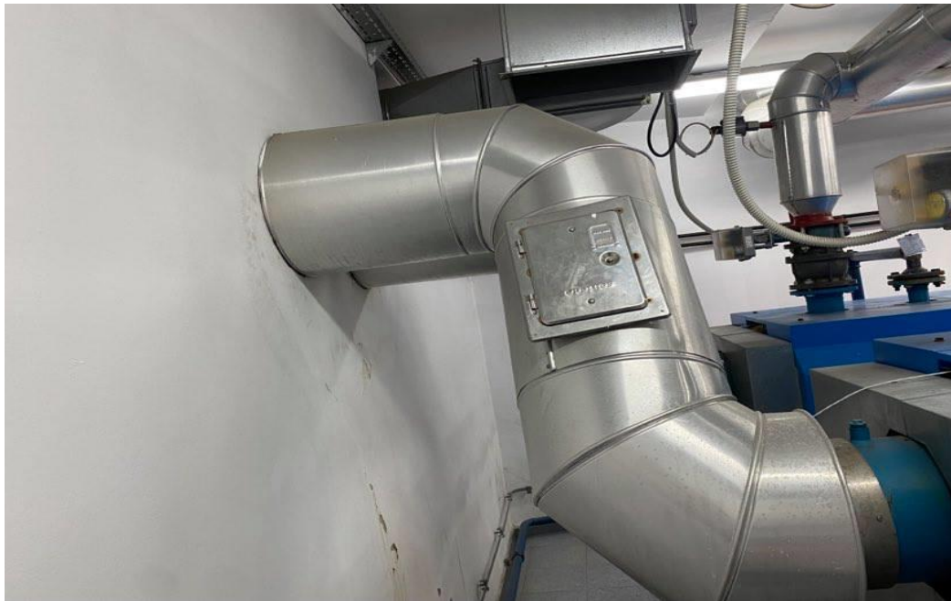
Slika 5. Mjerno mjesto na dimovodu za mjerenja emisije dimnih plinova
