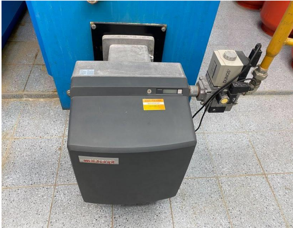
Slika 3. Plinski plamenik s dovodom plina
