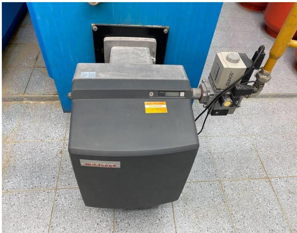
Slika 3. Plinski plamenik s dovodom plina
