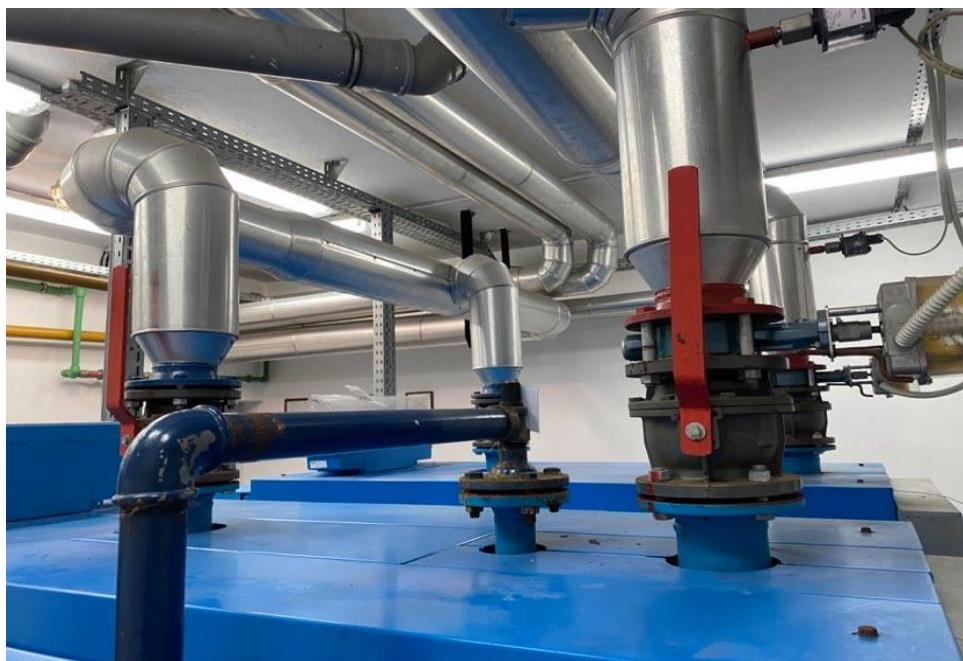
Slika 4. Sustav cijevi s ventilima za dovod i odvod vode u plinski kotao
