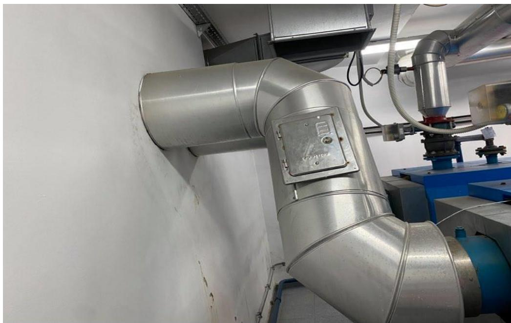
Slika 5. Mjerno mjesto na dimovodu za mjerena emisije dimnih plinova
