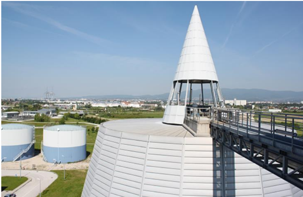
Slika 11. Vrh digestora s pogledom na grad [18]
