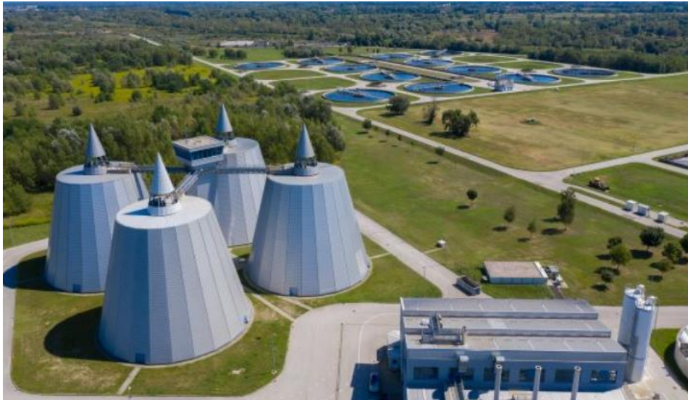
Slika 9. Digestori bioplinskog postrojenja u Zagrebu [17]
