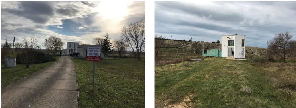
Slika 4. a) Vodocrpilište Jezerce, b) vodocrpilište Boljkovac (Biondić et al., 2019.)
