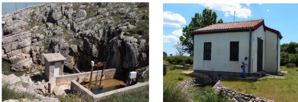
Slika 5. a) Izvorište Golubinka, b) vodocrpilište Oko (Biondić et al., 2019.)
