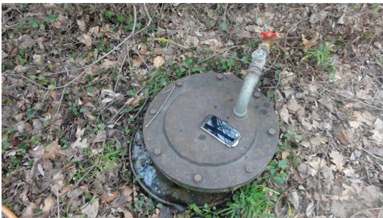
Slika 10 Ušće bušotine VTT-1 (Škrlec, 2020)
