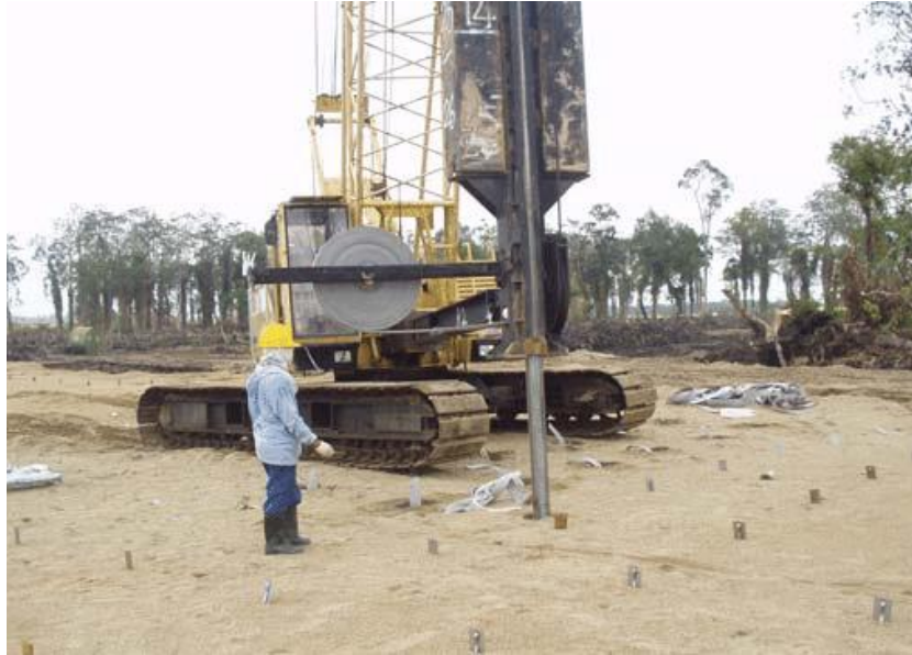
Slika 16. Stroj za statičko utiskivanje drenova (Liu i sur. 2009)
