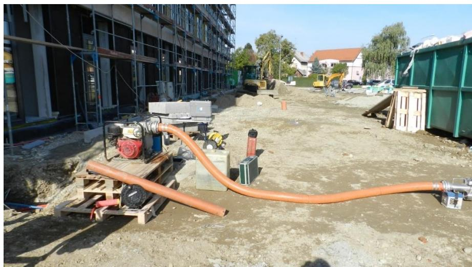
Slika 14. Primjer postavljanje crpke za pokusno crpljenje.
