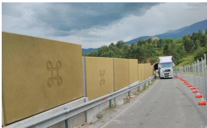
Slika 4. Ruconbar (engl. Rubberised Concrete Noise Barriers) – ekološka barijera za zaštitu od buke (Beton Lučko, 2012.)
