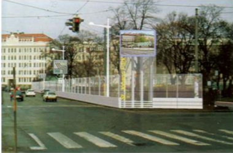
Slika 7. Prozirna barijera za zaštitu od buke (Stanzel, 2000.)
