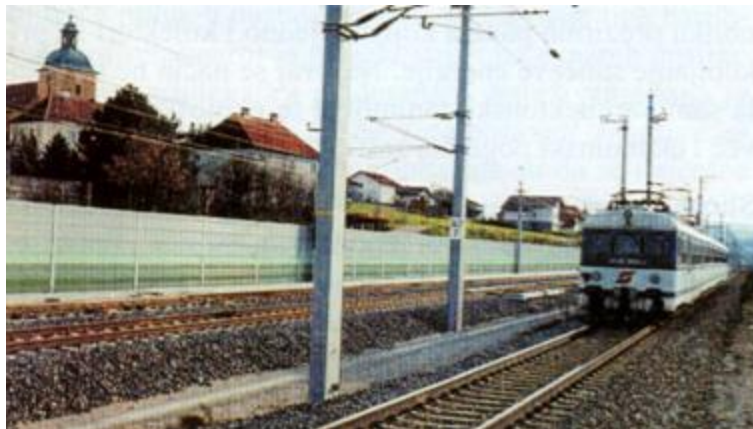
Slika 8. Zaštitna barijera uz željezničku prugu (Noise protection, 2003.)
