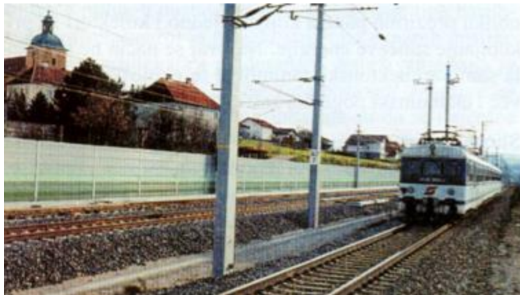
Slika 8. Zaštitna barijera uz željezničku prugu (Noise protection, 2003.)
