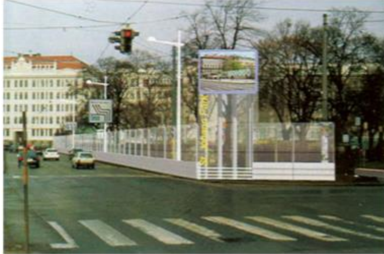
Slika 7. Prozirna barijera za zaštitu od buke (Stanzel, 2000.)
