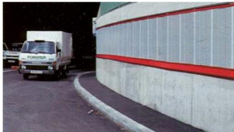
Slika 6. Obloženi zidovi podvožnjaka apsorbirajućim panelima (Noise protection, 2003.)
