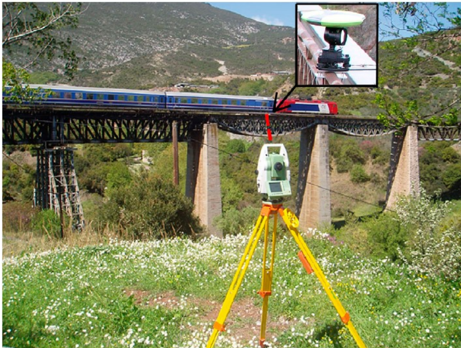
Slika 9. Željeznički most Gorgopotamos i robotska totalna stanica korištena za mjerenja s fokusom na reflektor [29]
