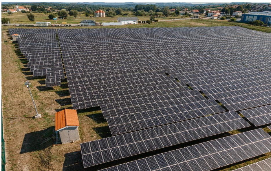
Slika 11. Fotonaponska solarna elektrana u Konjšćini [20]
