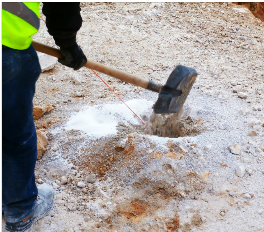
Slika 13. Čepljenje vertikalnih minskih bušotina u kamenolomu „Špica“
