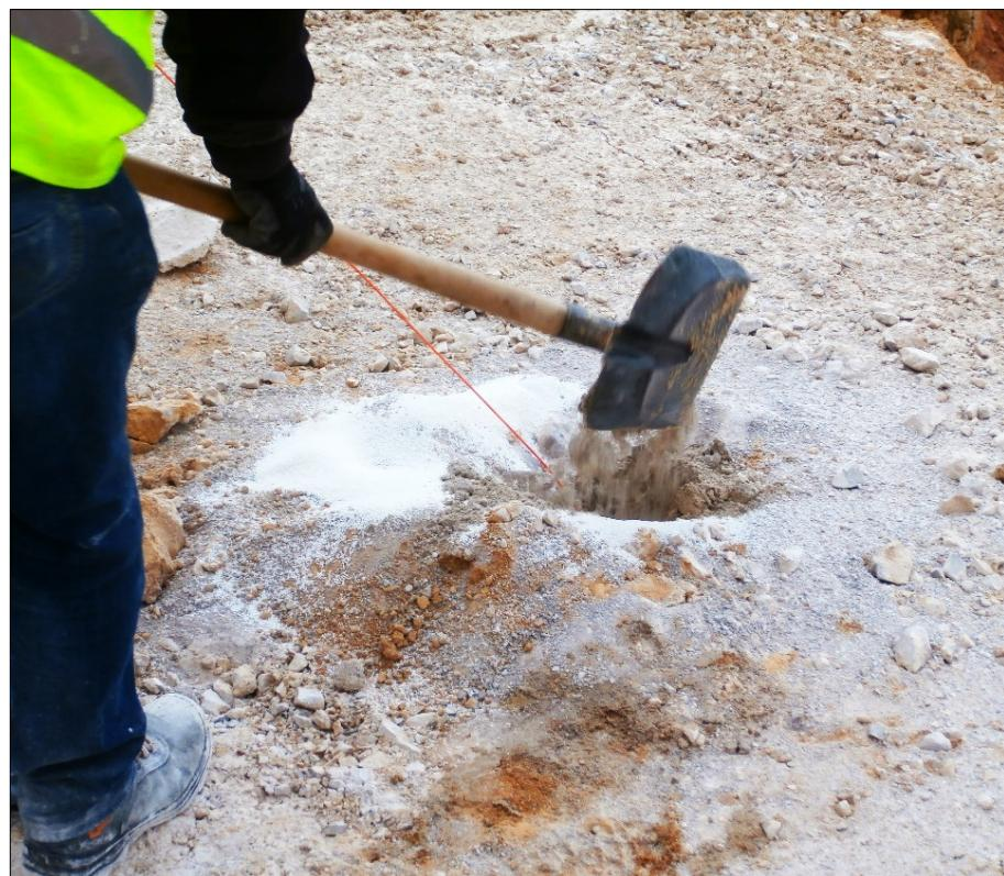
Slika 13. Čepljenje vertikalnih minskih bušotina u kamenolomu „Špica“
