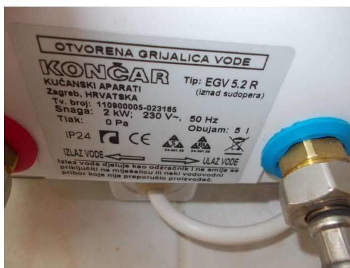
Slika 19 Natpisna pločica električnog bojlera marke Končar [15]
