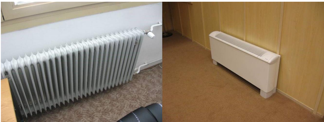
Slika 14 Člankasti radijator (lijevo) i ventilokonvektor (desno) [15]
