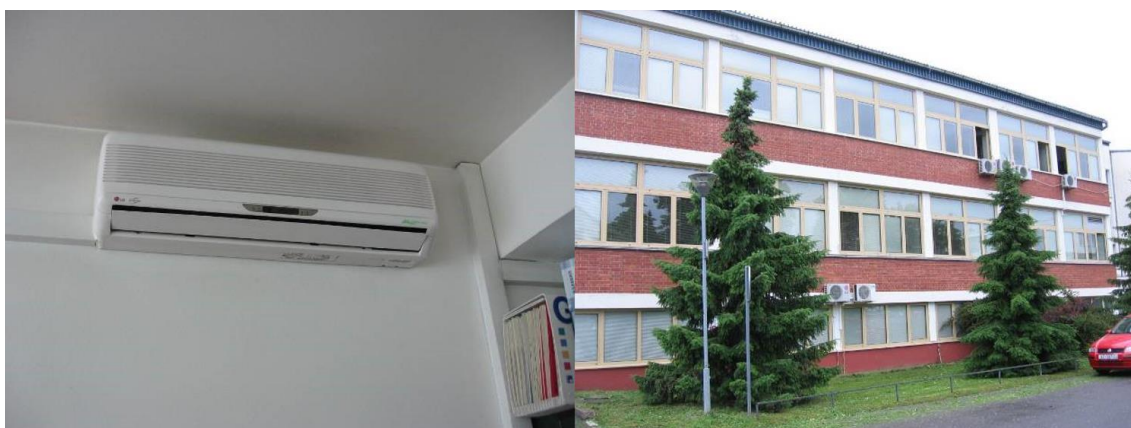
Slika 15 Rashladni uređaj, unutarnja jedinica (lijevo), vanjska jedinica (desno) [15]
