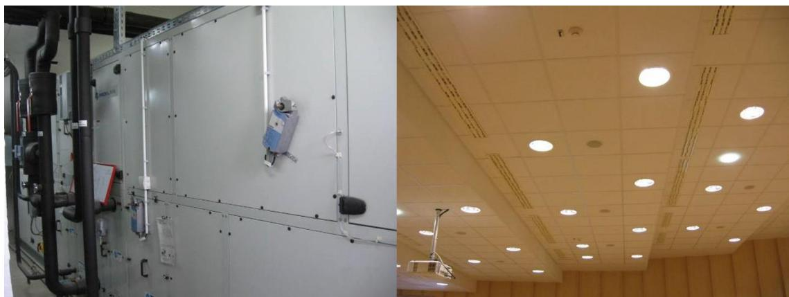
*Slika 17 Klima komora Proklima KU 6-M-DU50S-S (lijevo), elementi za distribuciju kondicioniranog zraka (desno) [15]*
